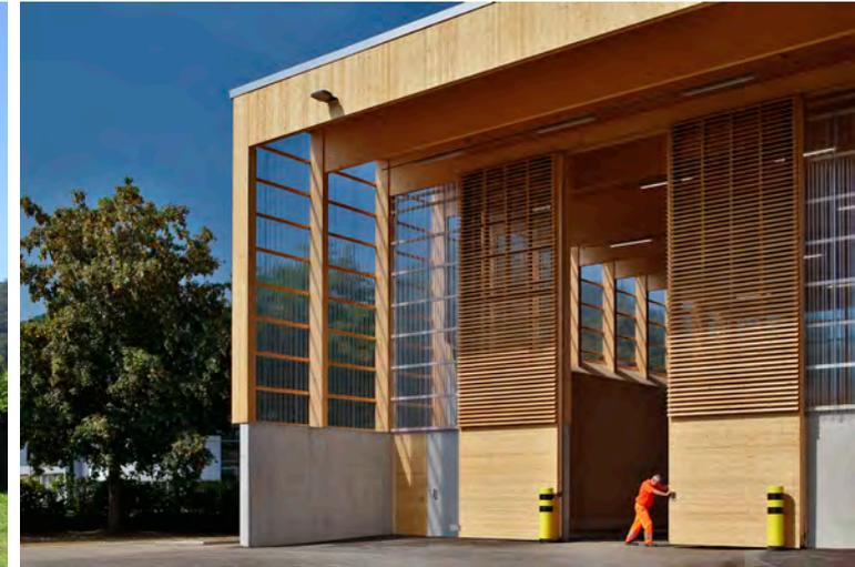
Das am häufigsten auftretende Problem bei Salzhallen älteren Typs ist, dass Salz in Konstruktionshohlräume gelangt und dort zu Bauschäden führt. Alle Bauelemente der neuen Halle sind daher vollständig offen und hohlraumfrei konzipiert. Eventuelle Schäden können frühzeitig erkannt und beseitigt werden.
