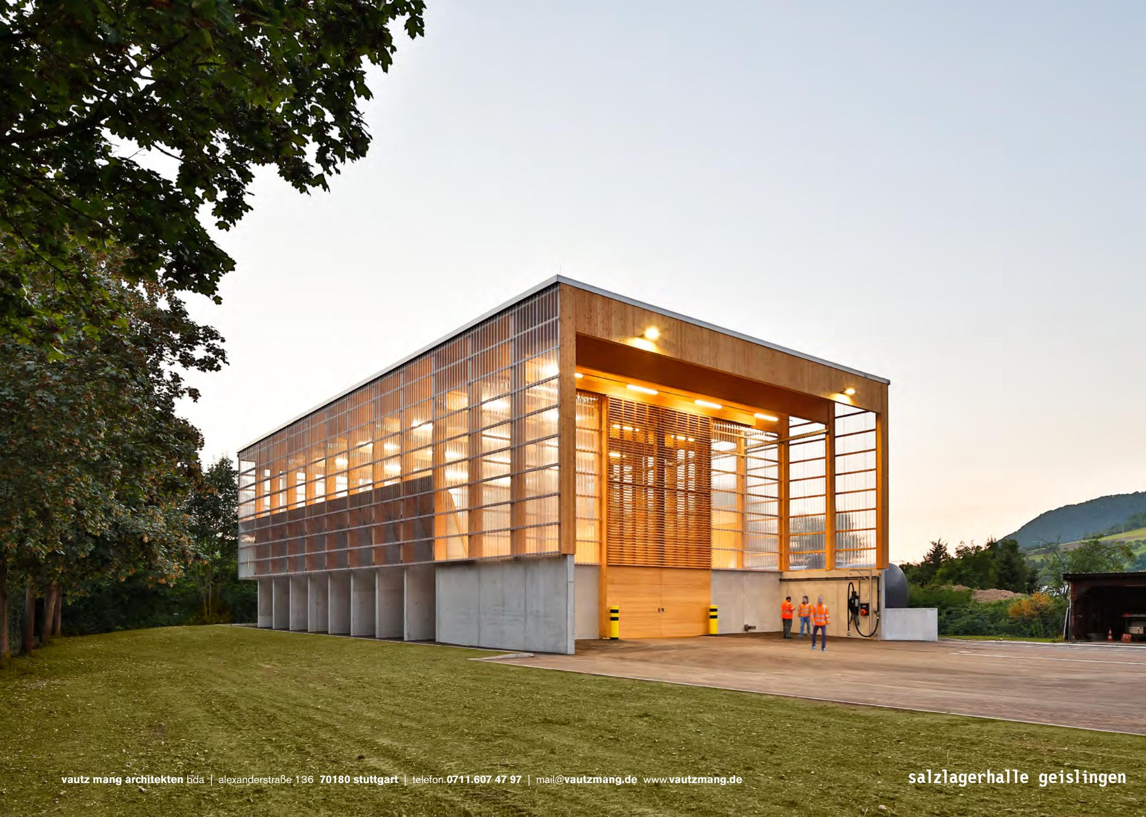
Durch geänderte Logistik im Streusalzvertrieb entsteht für neue Salzlagerhallen die Anforderung einer lichten Durchfahrtshöhe von 10,00m für Sattelschlepper mit gekippter Liefermulde. Gleichzeitig erhöhen sich häufig aus Platzgründen auch die gewünschten Schütthöhen auf 5,00 – 7,00m. Diese Aufgabe stellte sich auch für die neue Salzlagerhalle der Straßenmeisterei Geislingen.
